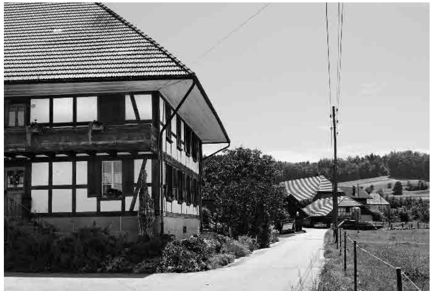
5 Bauernhaus mit Sandsteinkeller, 1844
