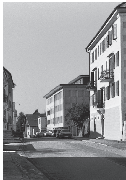
11 Anc. fabrique de boîtes de montre
