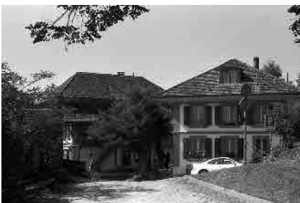
14 Wirtshaus «zur Mühle»
