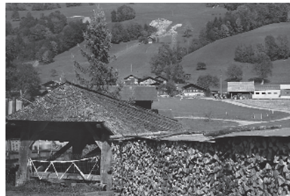
7 Gedeckte Holzbrücke, 18. Jh.
