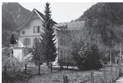
31 Ehem. Gasthof «Bahnhof»
