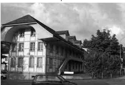
15 Ehem. Schulhaus in Papiermühle
