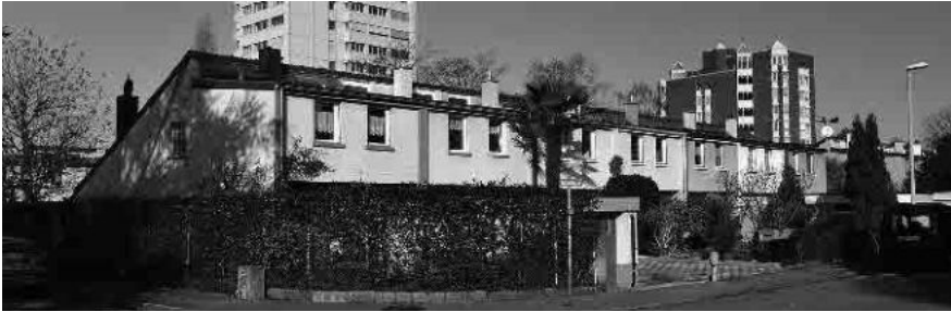
35 Pultdachbauten an der Lilienstrasse
