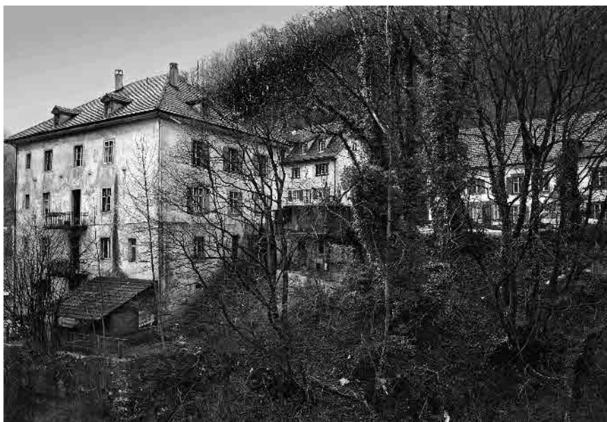
4 Ensemble an der Kantonsstrasse
