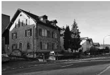
15 Arbeiterhäuser der Fabrik
