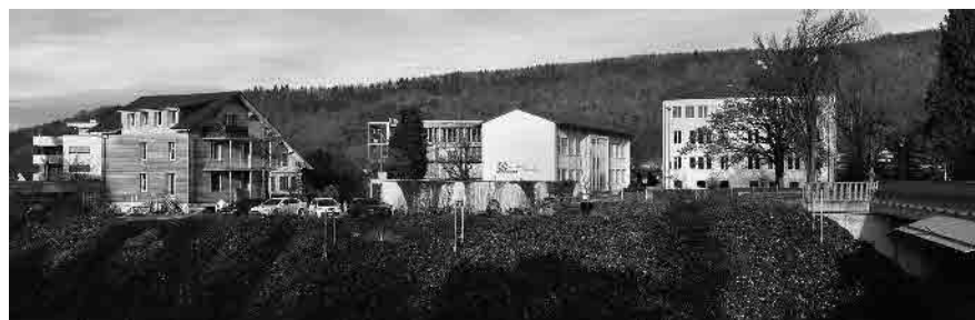
58 Blick über den Bahneinschnitt
