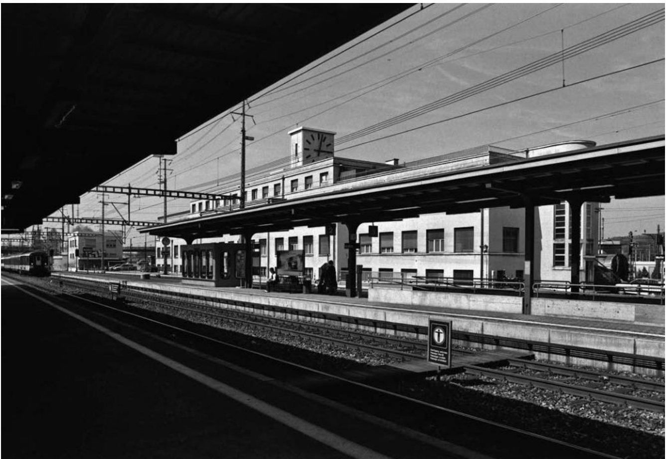
39 Bahnanlagen und Hauptgebäude des Rangierbahnhofs von 1930
