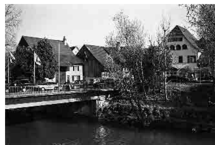
19 Autobrücke über die Birs
