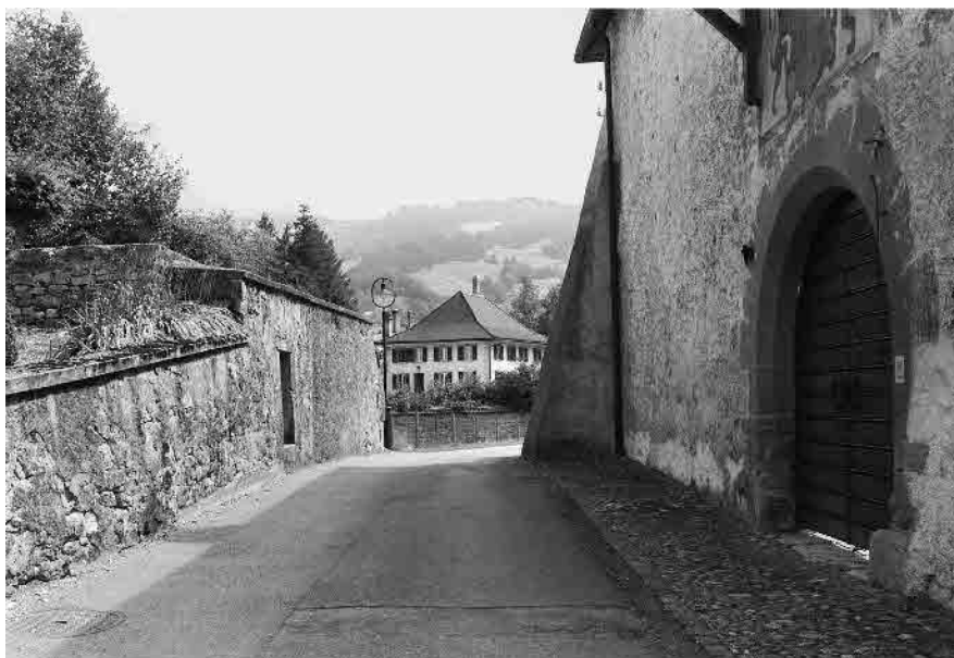
5 Etroit passage entre l'ancienne ville et son faubourg
