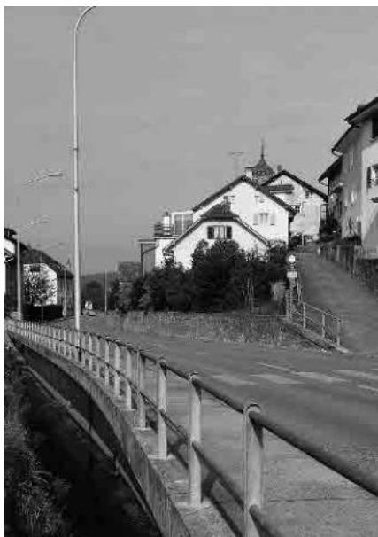
9 La Vendline canalisée
