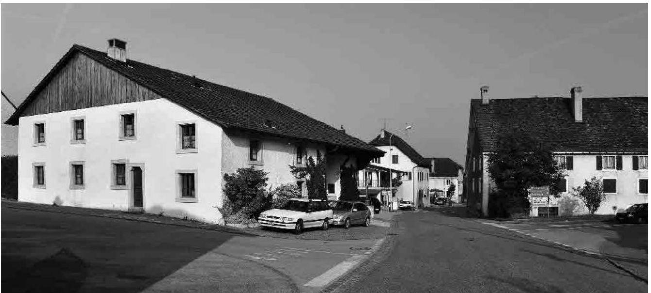
10 Route des Fontaines
