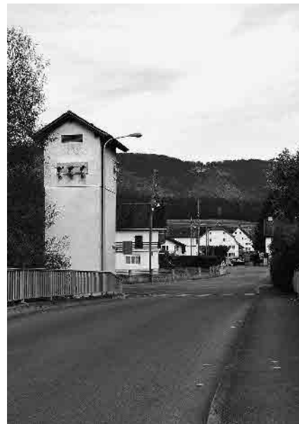
2 Pont sur la Scheulte
