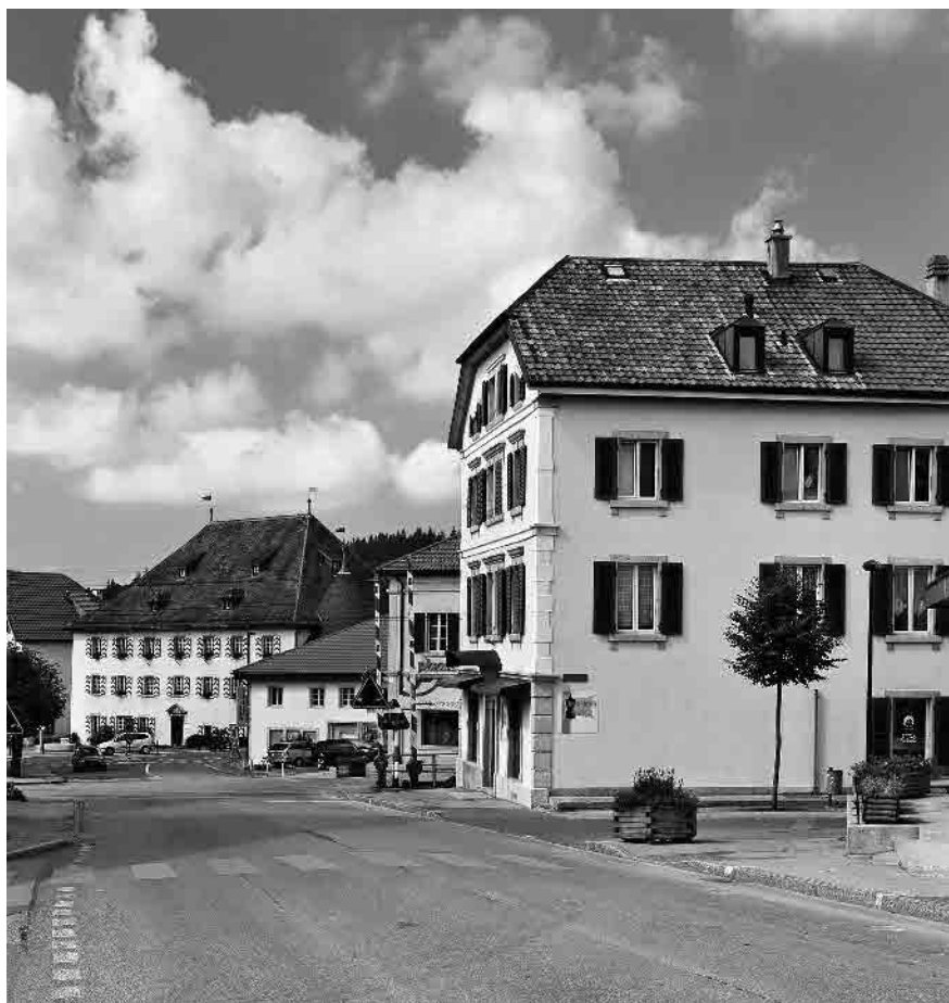
11 Place du 23-Juin, ancienne Châtellenie, 17 e s.
