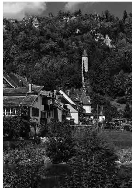
30 Mur d'enceinte et tour
