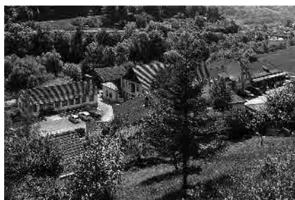
4 Ancien moulin et ateliers
