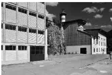
3 Anciens fours à chaux
