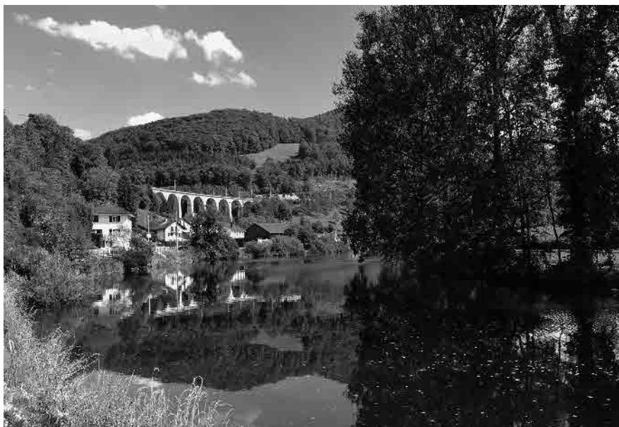
6 Doubs et viaduc de 1877/1930
