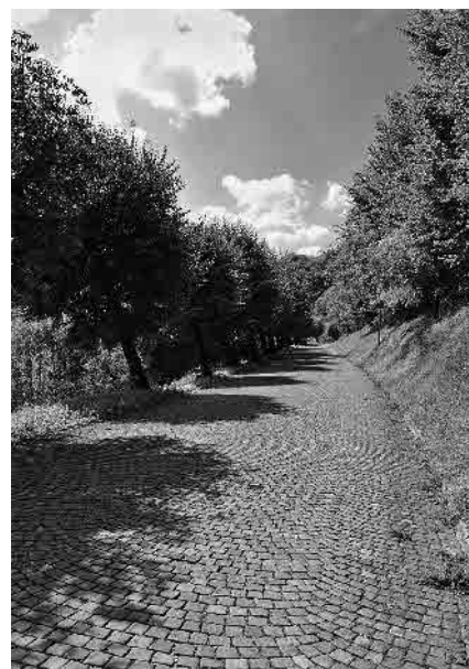
5 Route de la Gare
