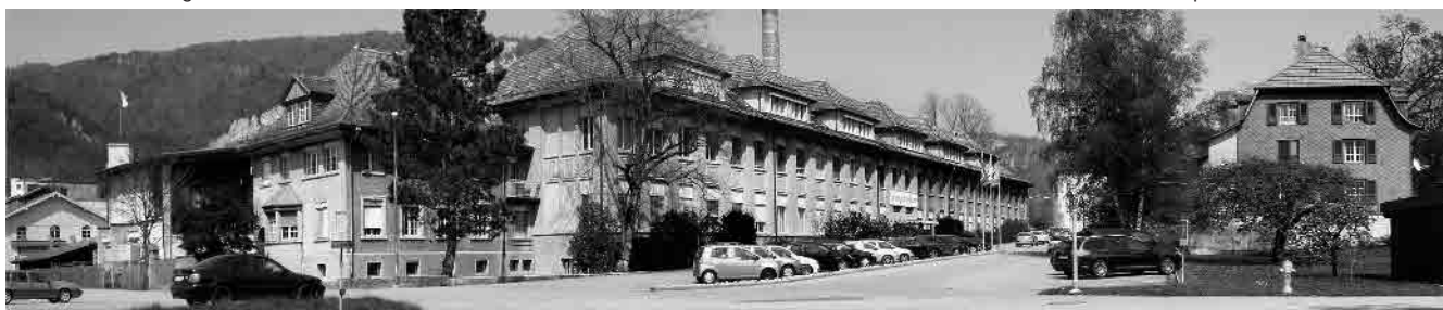
35 Ehem. Produktions- und Verwaltungsbau der Tela, 2. V. 20. Jh.
