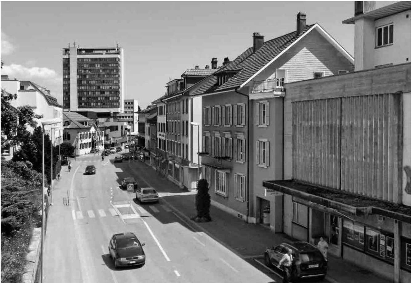
8 Bielstrasse, Hochhaus Centro, 1972
