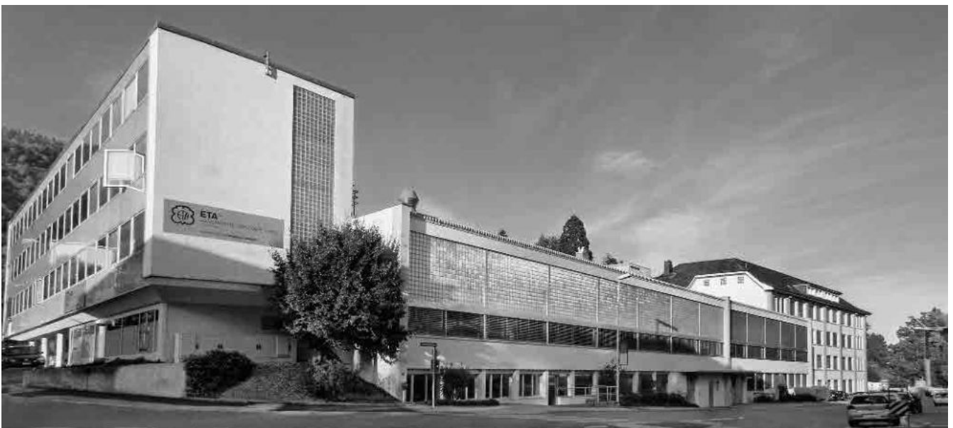
40 Ehem. Maschinenfabrik Technica, 1957/63, Uhrenfabrik ex Felsa, 1917, heute ETA-Werk 3
