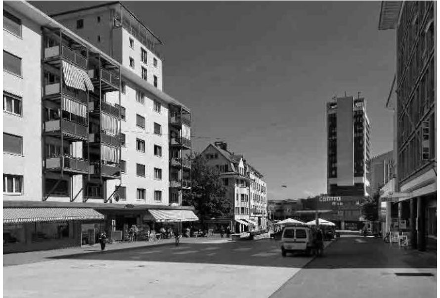
11 Marktplatz, im Hintergrund Hochhaus Centro, 1972
