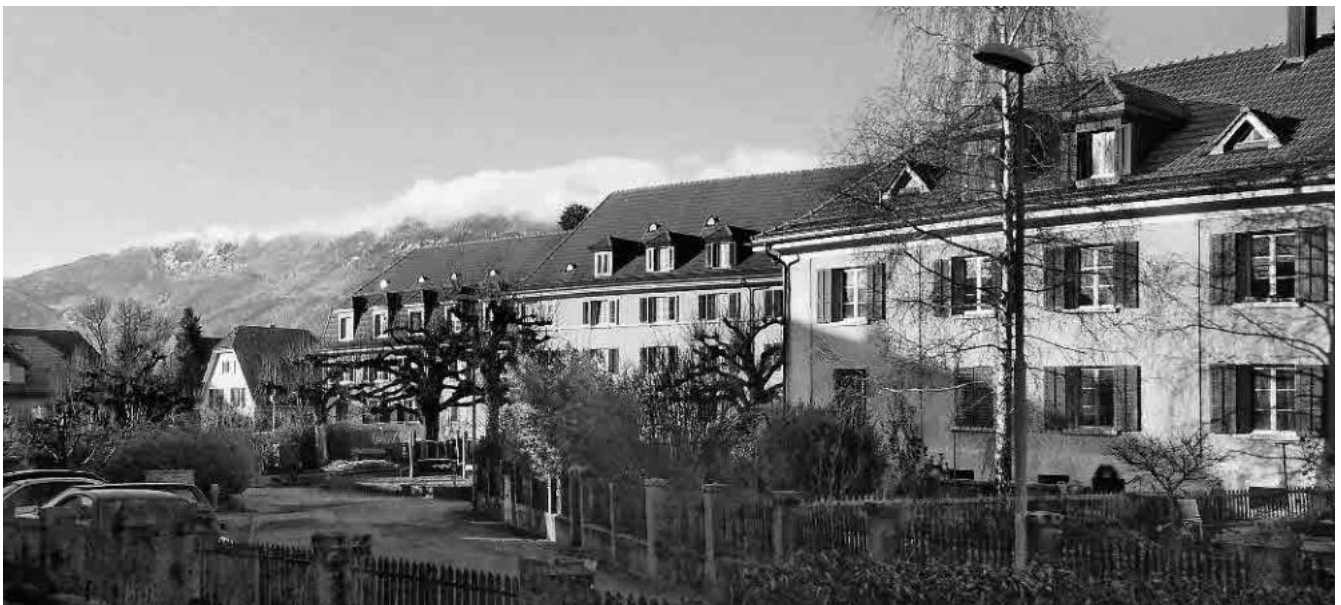
93 Dilitschquartier, kommunale Wohnsiedlung, 1916–18
