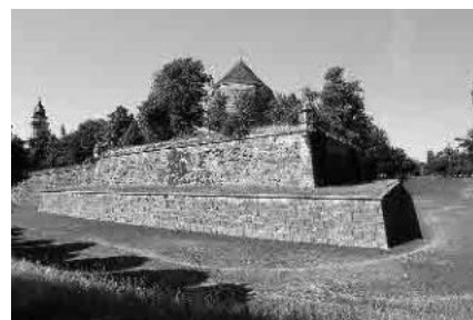
20 Riedholzschanze und Graben
