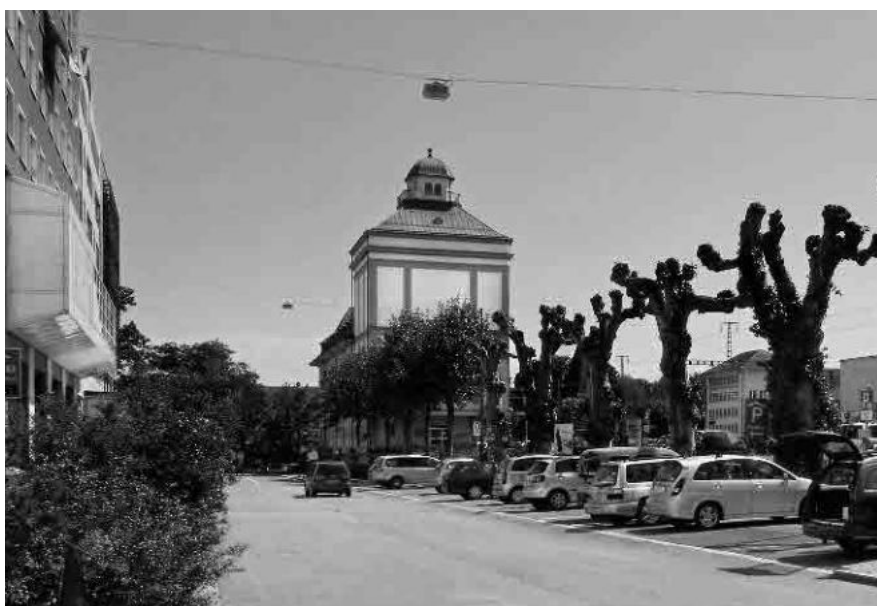
54 Westbahnhofplatz, im Hintergrund Landiturm, 1922
