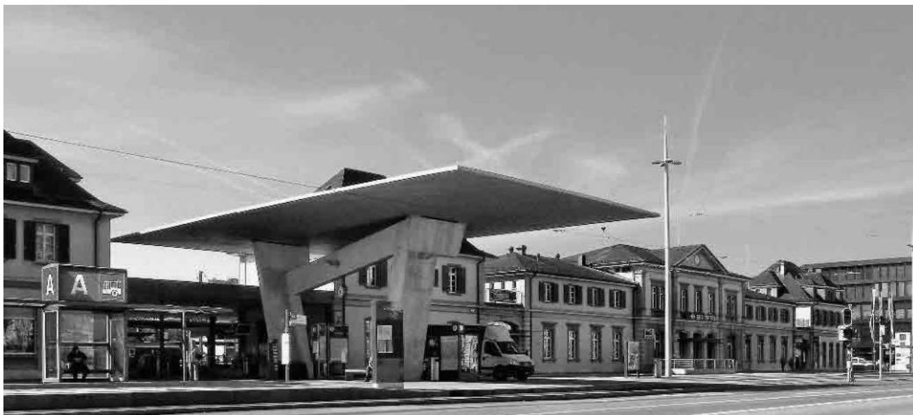
31 Hauptbahnhof und Flügeldach für «Bipperlisi»
