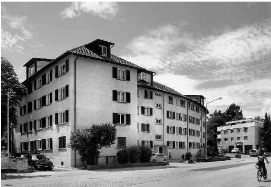
41 Südlich des Hauptbahnhofs, Zuchwilerstrasse
