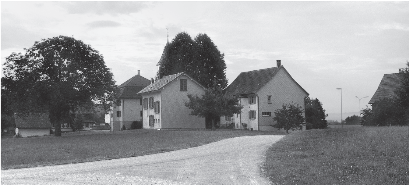
6 Kath. und ref. Pfarrhaus sowie Schulgebäude
