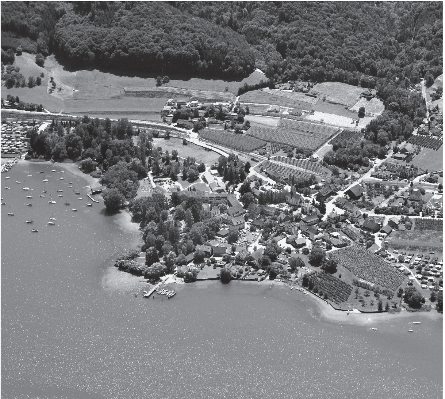
Flugbild Bruno Pellandini 2007 © Amt für Denkmalpflege des Kantons Thurgau
