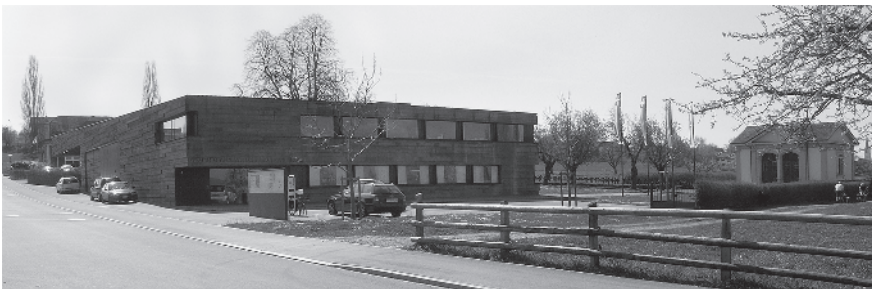
8 Gemeindehaus und Werkhof, 2003
