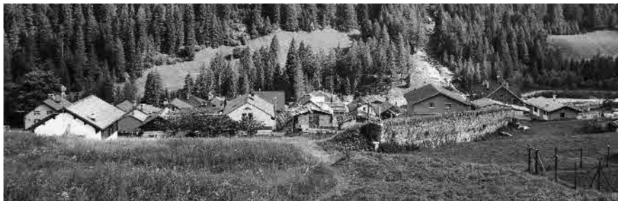
1 Vista da nord e da monte
