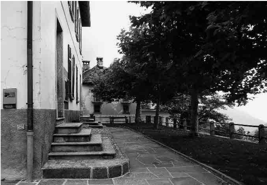
6 La facciata della Casa comunale di inizio sec. XX
