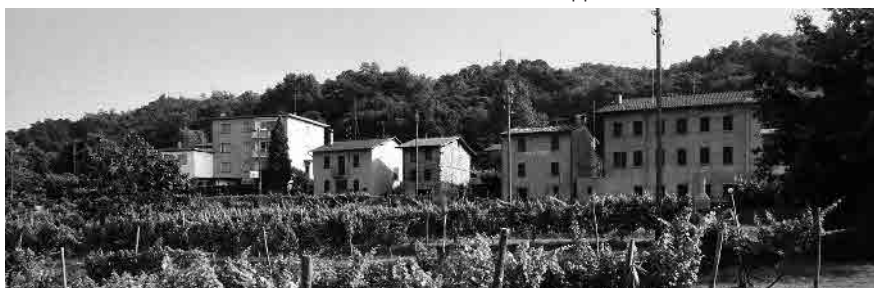
11 Vista su Gaggio da nord
