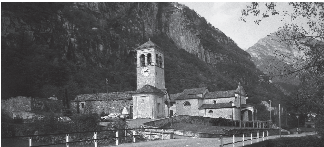
4 Vista da sud sul complesso con la parrocchiale dei SS. Giovanni e Assunta del sec. XVI
