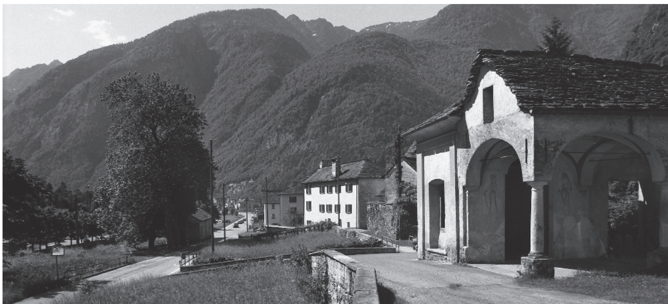
3 Ossario del sec. XVIII in primo piano e Cevio vecchio sullo sfondo, visti da nord
