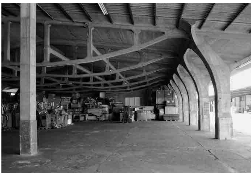
68 La tettoia dei Magazzini; ing. R. Maillart, 1923
