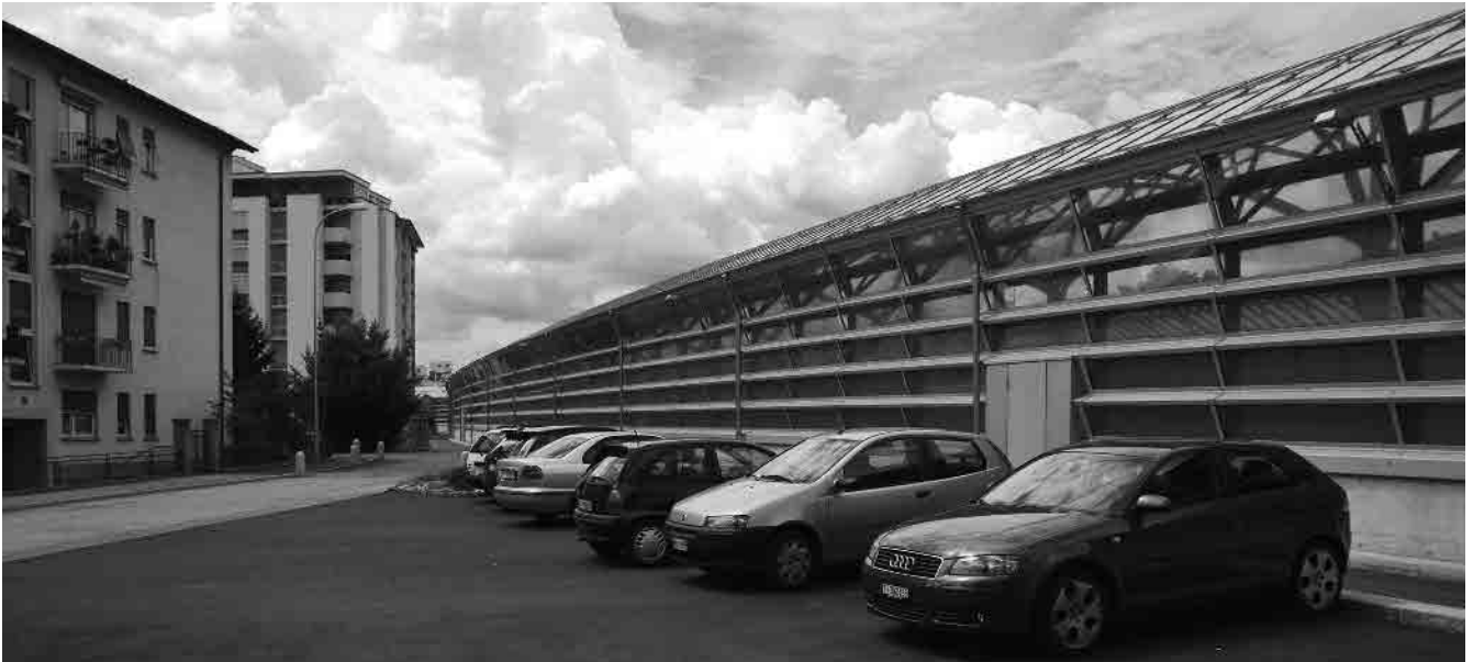
44 Barriere antirumore dell'autostrada, arch. M. Botta
