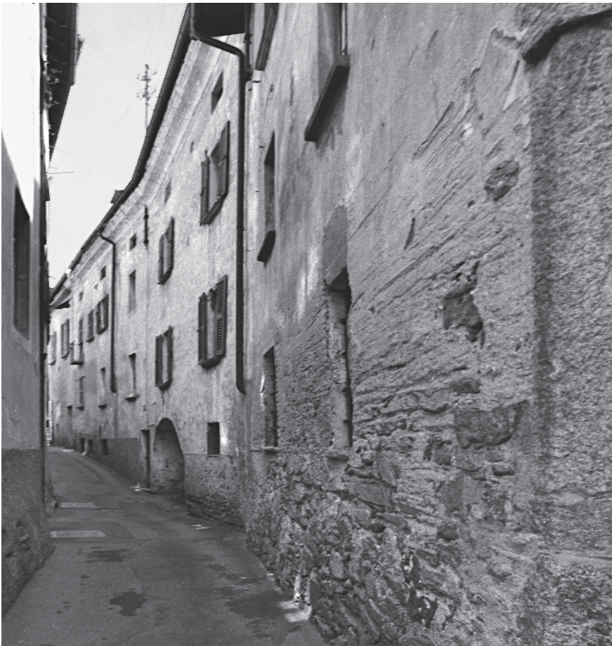
10 Lungo fronte rurale sul percorso interno principale
