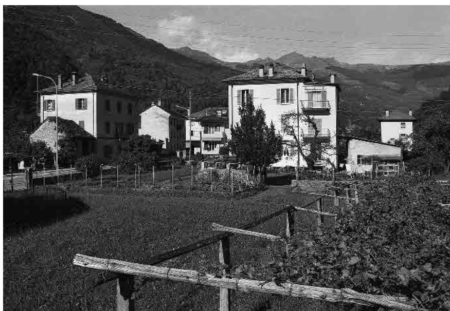
6 Spazi verdi in diretta continuità con l'edificazione lungo strada
