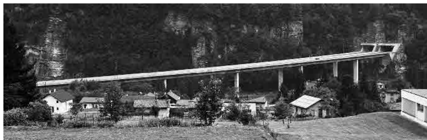
29 Viadotto autostradale, a sud est dell'insediamento
