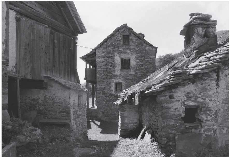
8 Edificio abitativo e edifici utilitari all'estremità ovest del nucleo
