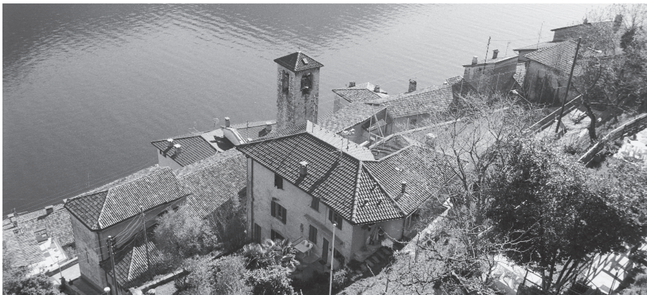
1 Vista dall'alto sulle coperture in tegole
