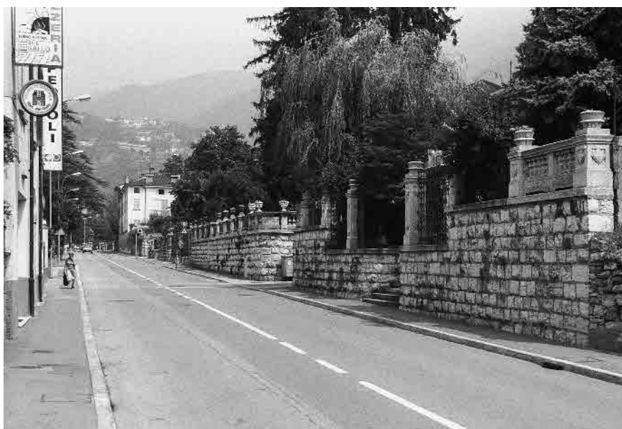
17 Recinzioni ai giardini in Via Turconi
