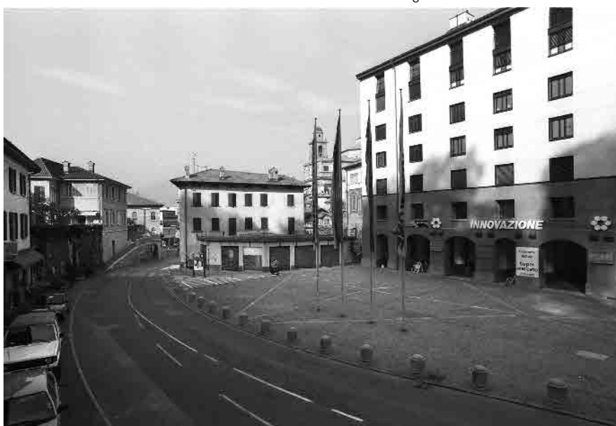
46 La ex Filanda Bolzoni, restauro del 1986
