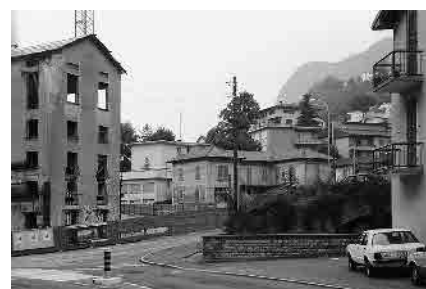
47 Prima del restauro
