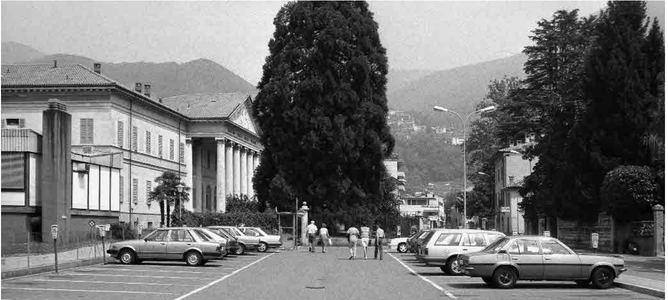
20 Accademia Architettura della Svizzera Italiana; arch. L. Fontana, 1853, già convento dei Cappuccini e ospedale
