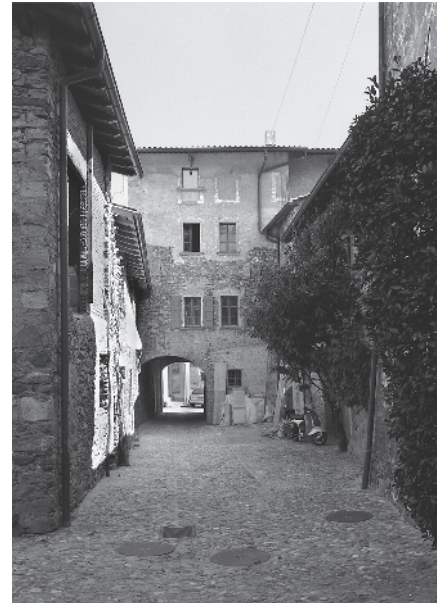
12 Parte di complesso rurale
