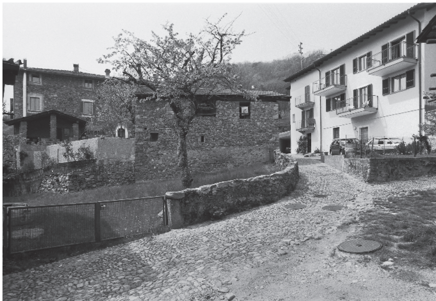
2 Vecchi edifici riattati
