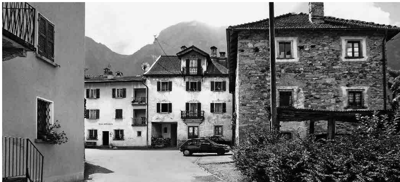
11 Ampliamento a piazza della strada di attraversamento
