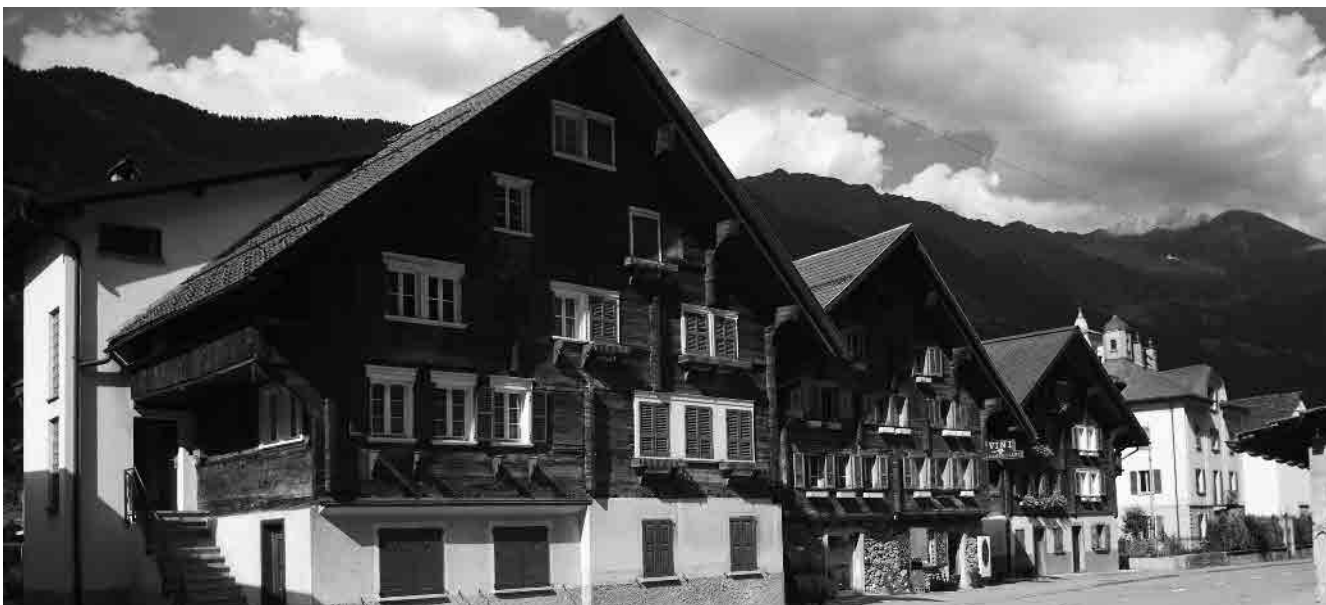
6 La via di attraversamento
