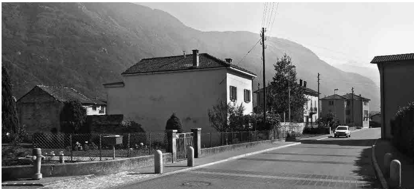
19 Edificazione lungo strada, inizio sec. XX
