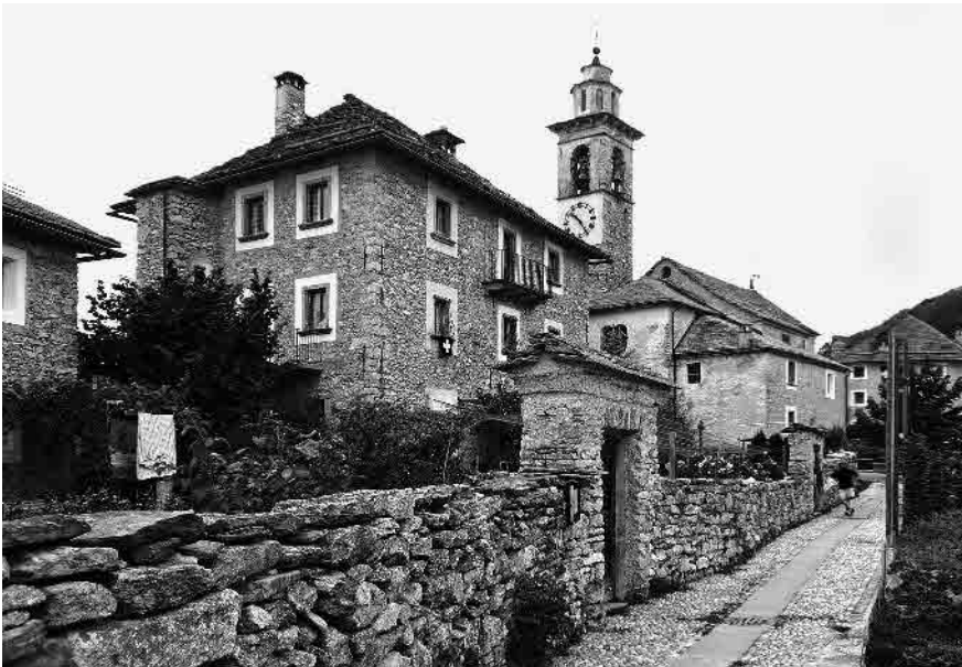
6 Dimora in muratura a vista, sec. XVII
