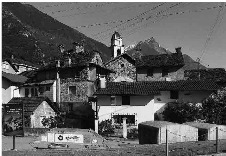
6 Accesso nord all'insediamento dalla strada cantonale
