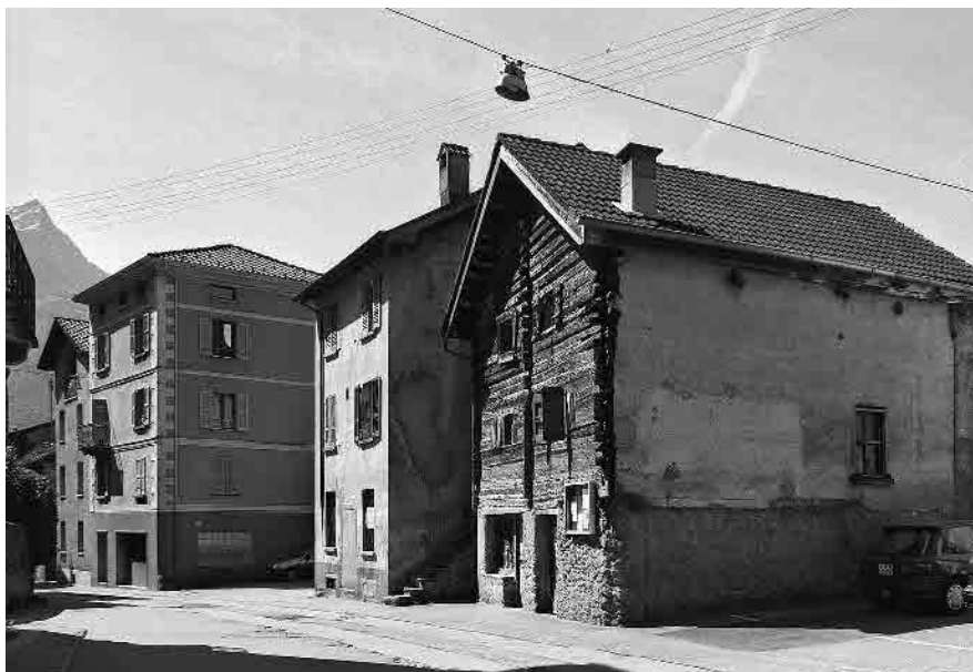
13 A sud della cappella: tipi e orientamenti diversi
