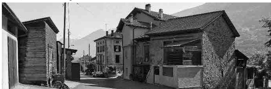
24 Orino, a sud del corso d'acqua
