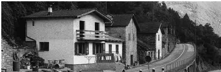
1 Insieme dei grotti di Rongie addossati ai piedi del pendio
