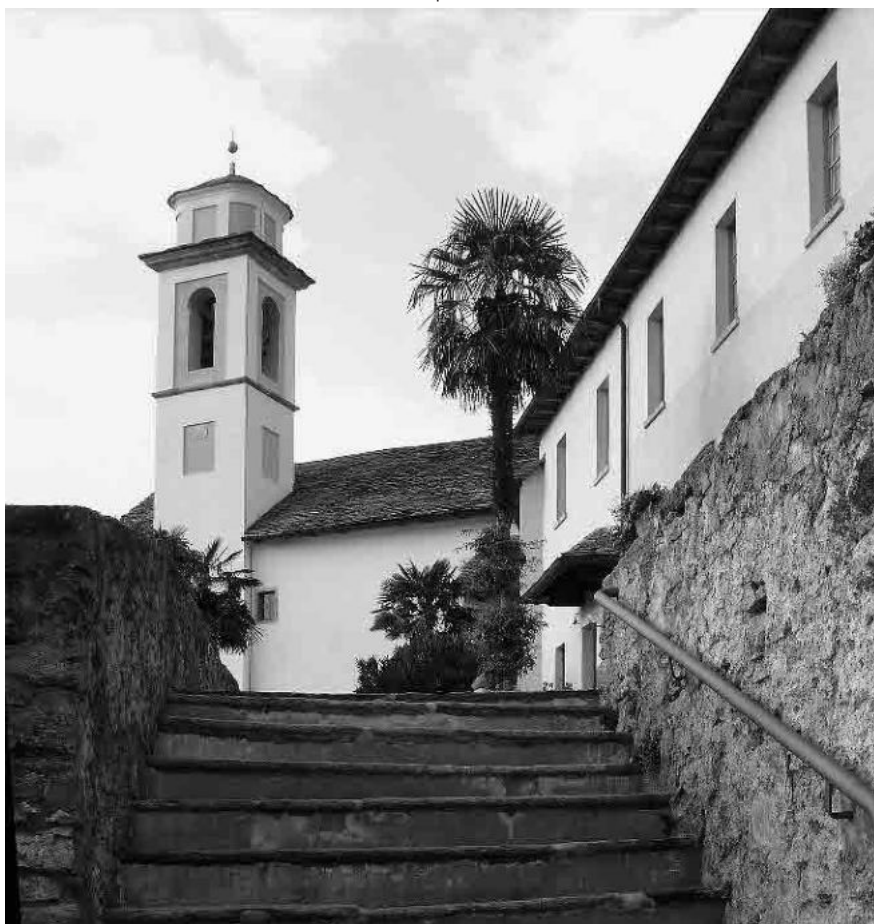
2 Accesso alla terrazza aperta verso valle
