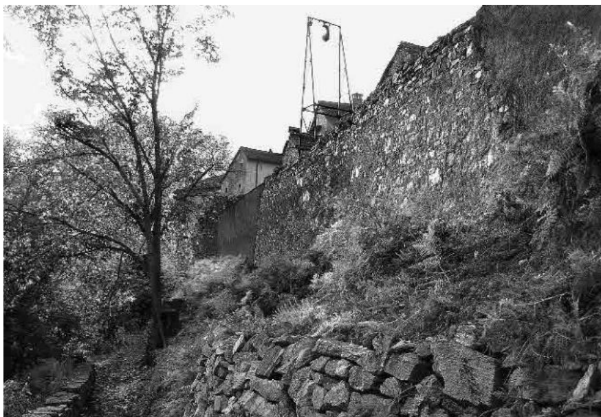
1 Cinta muraria sud occidentale al complesso
