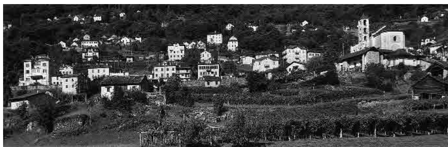
22 Vista da est; edificazione lungo strada e in pendio
