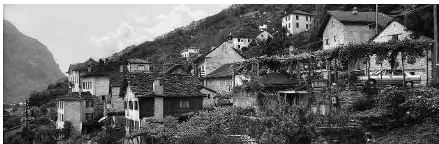
17 Vista da nord sul nucleo di S. Carlo, in pendio
