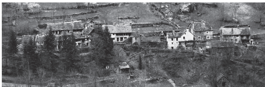
43 Mondada, terrazzamenti sullo sfondo, vista da sud
