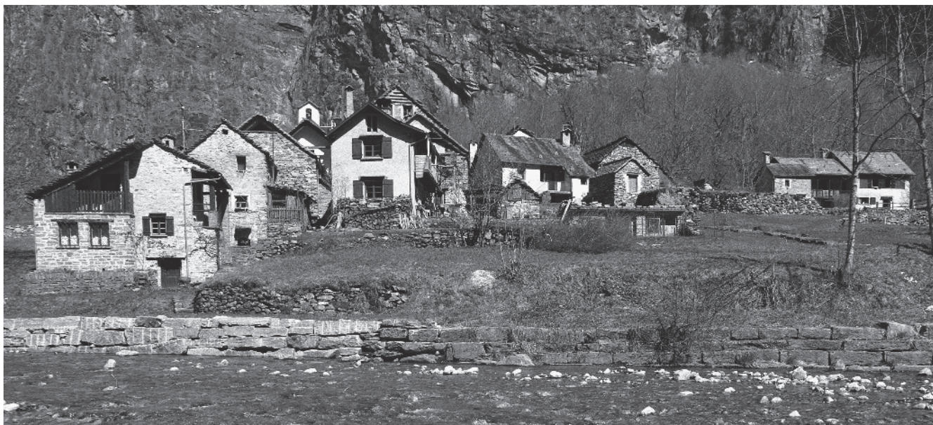
17 Rosèd, panoramica da sudovest
