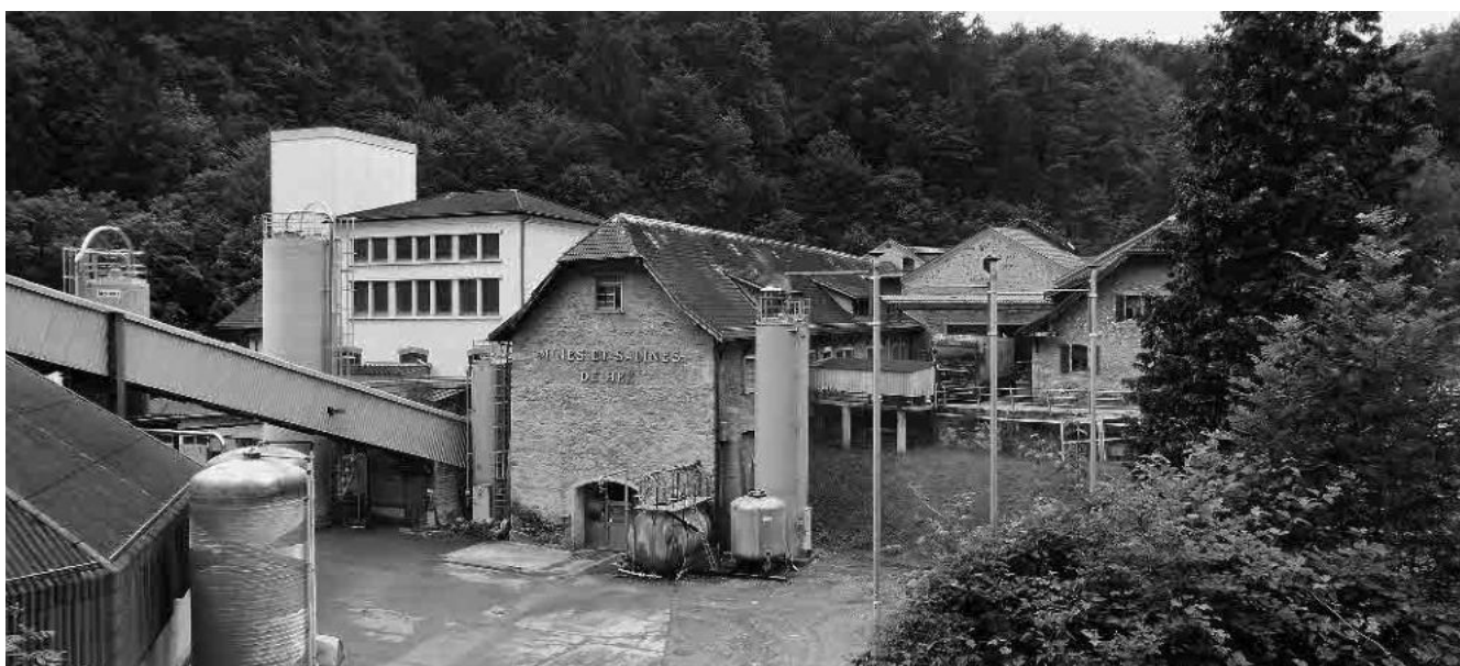
5 Bâtiments d'exploitation et dépôt borgne de 1997
