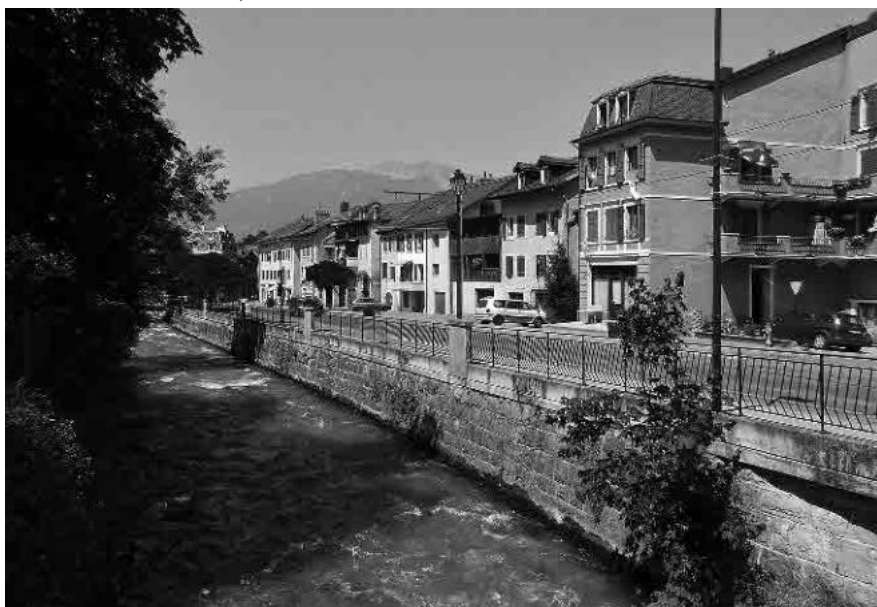
19 Cours endigué de la rivière de l'Avançon
