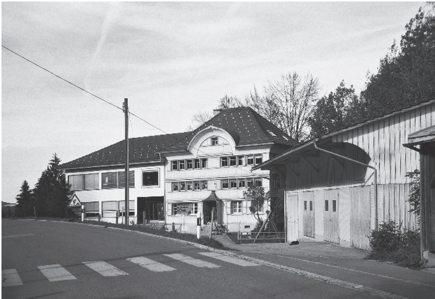
17 Schulhaus zur Linde, 1780–90
