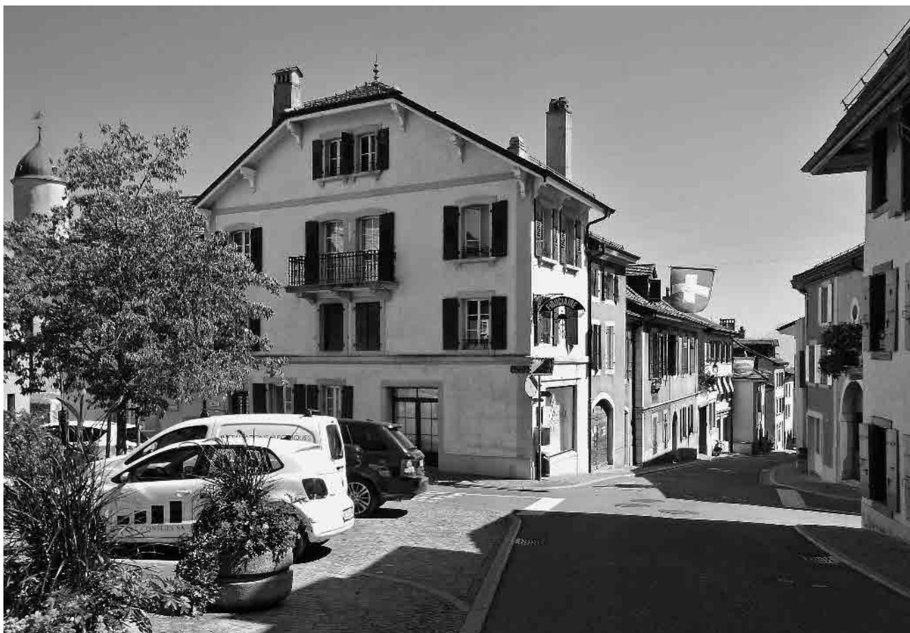
6 Extrémité supérieure de la Grande-Rue
