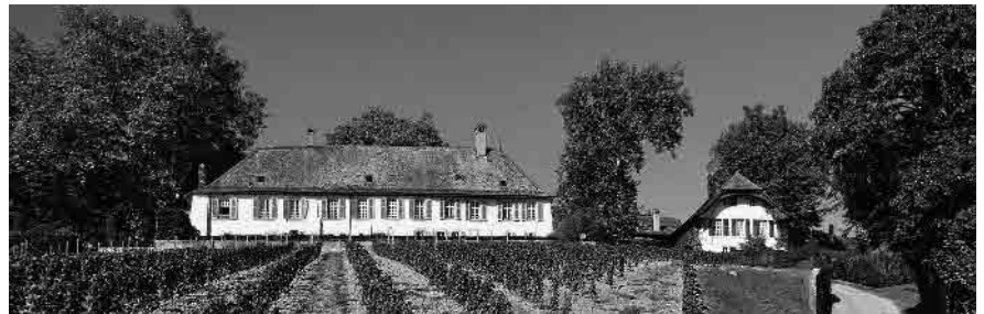
10 Manoir de Riencourt, façade méridionale, reconstr. vers 1721
