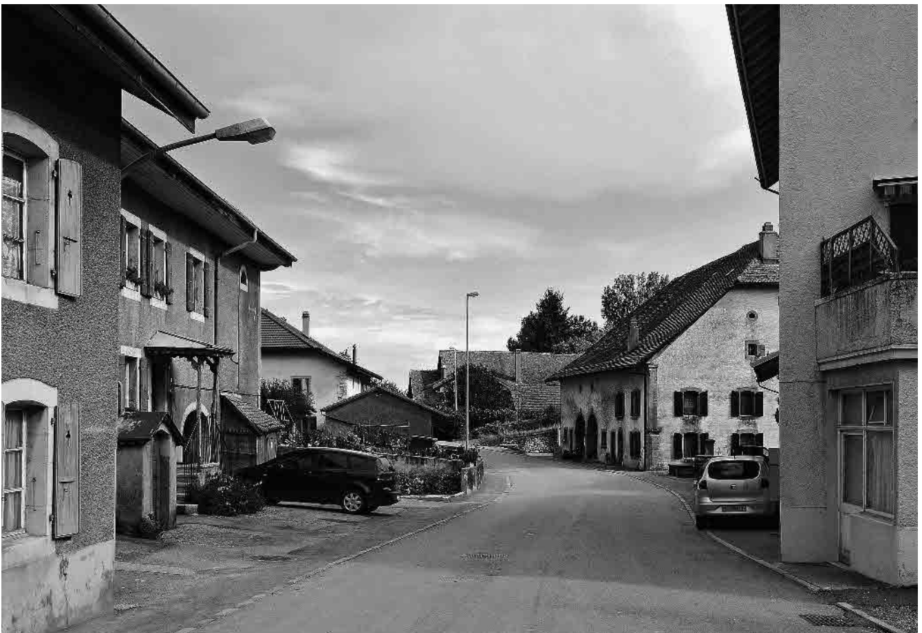
9 Partie inférieure le long de la rive gauche de la Venoge
